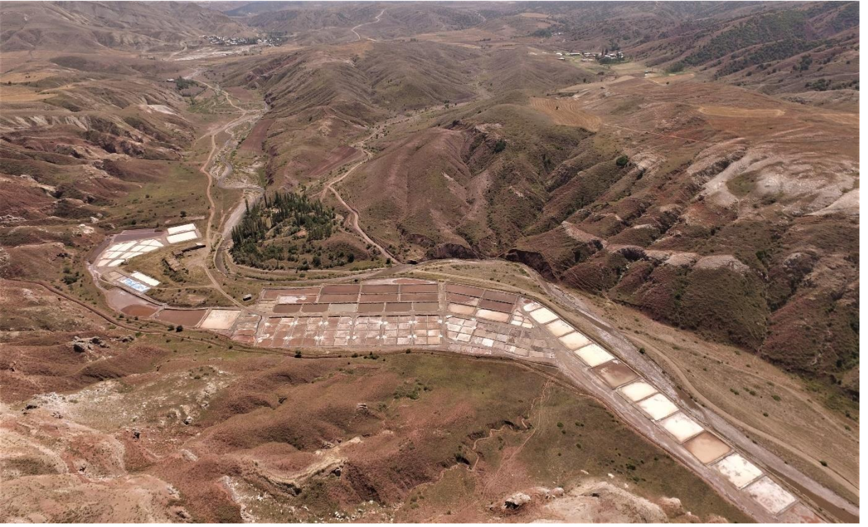
Şekil 2. Tuzlagözü Cedit Tuzlası
